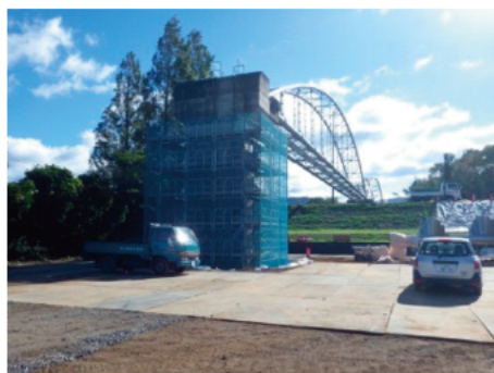
水道施設（水管橋）の耐震化（玉城町）
