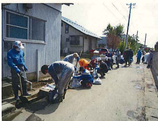
ボランティア活動（汚泥排除作業）
