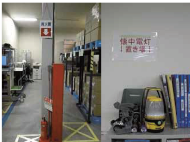
消火器・避難グッズ保管場所や、避難経路を蓄光表示
