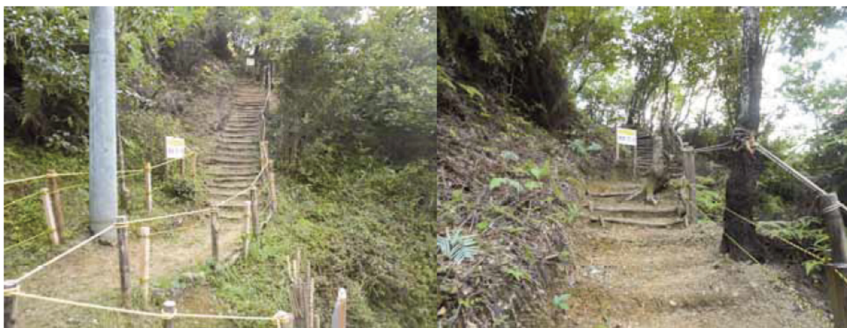
地区住民が協力して行った避難路の整備
