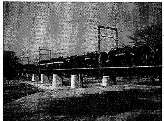
【同橋梁修繕後】
