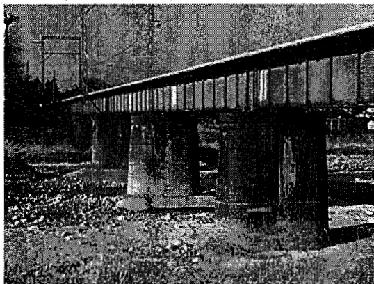
【三岐鉄道 宇賀川橋梁 橋脚修繕前】
