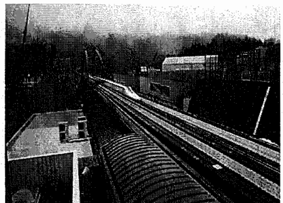
■リニア中央新幹線試験走行の様子
