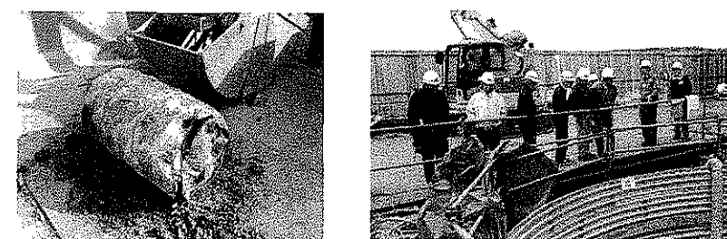
掘削されたドラム缶(溶剤を確認) 11 住民への現地説明会(H22.2.16)
