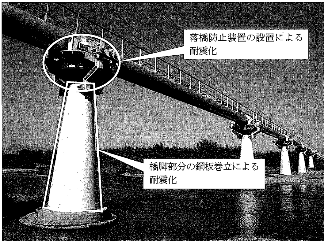
耐震化対策を行った員弁川水管橋(二期・後期)
