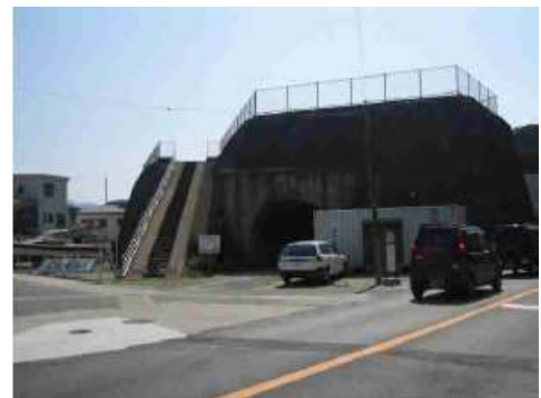
■避難マウンド （出典：沼津市地震・津波防災マニュアル）
