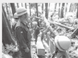
台風11号被害状況現地調査
