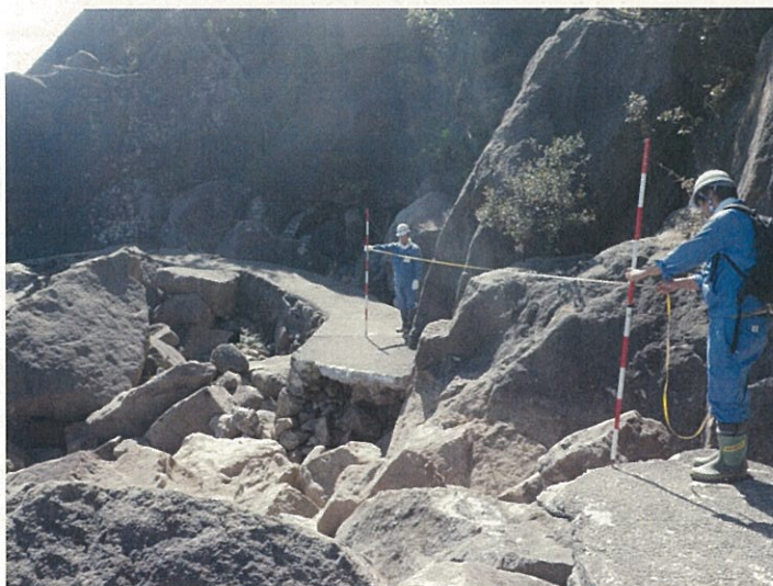
自然公園施設 (熊野市 鬼ヶ城周回道路)
