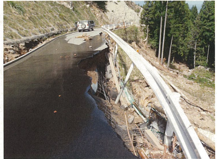
林道施設 (津市 経ヶ峰線)
