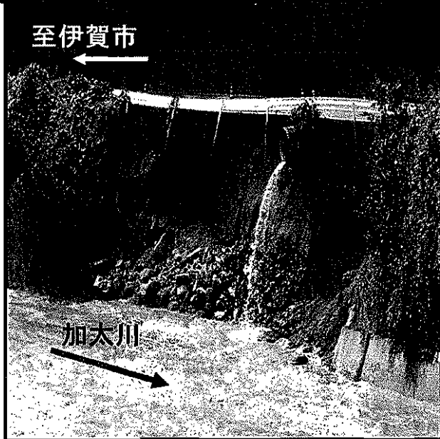
④ 国道25号(亀山市)【道路路肩崩壊】
