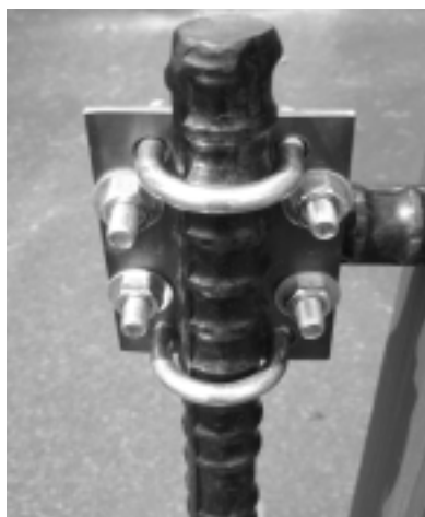
写真 1. Uボルトによる取付
