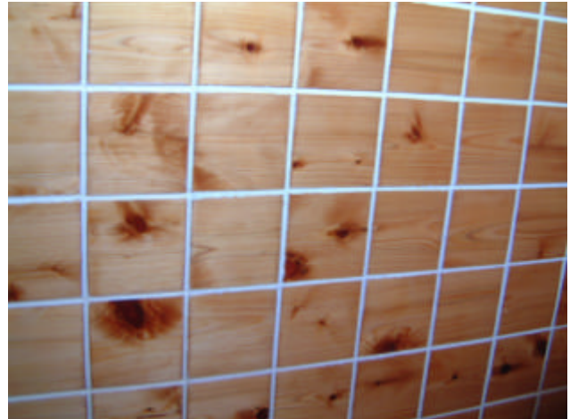
写真-1 実用化試験1年後の状態
