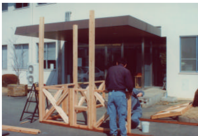
写真-2 組み立て状況
