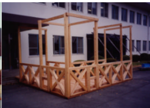
写真-3 スロープ全景
