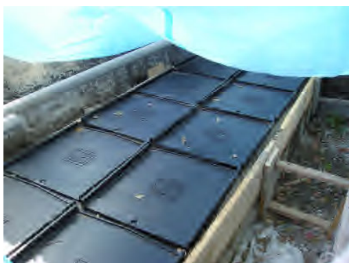
図 1 開発した光ケーブル保護部材
