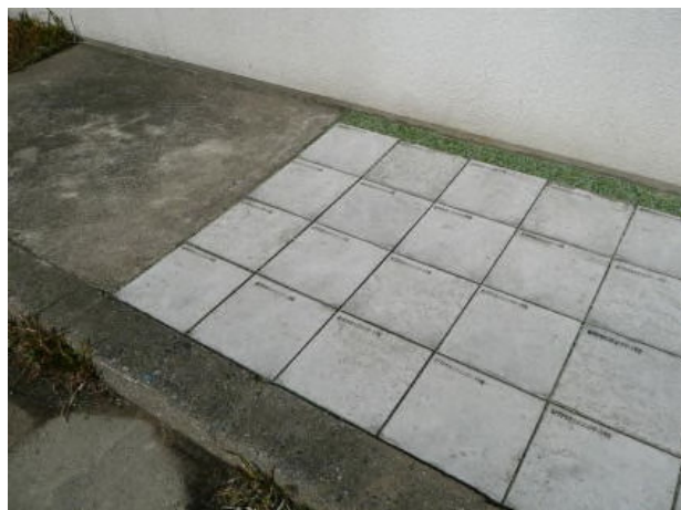
図3 FRP 粉末入りコンクリート製品の試験施工
