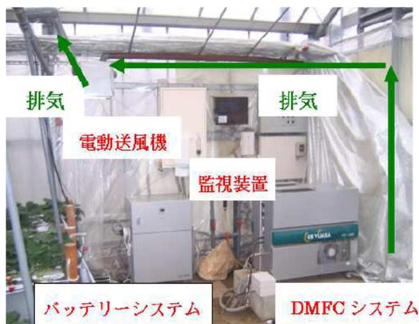
写真 1 燃料電池システムの構成
