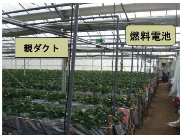
写真 2 送風ダクトの配管状況
