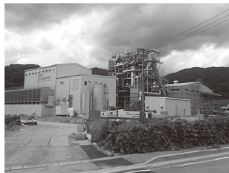
建設中の木質バイオマス発電所(松阪市)
