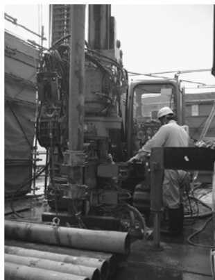
鋼管による掘削作業の様子
