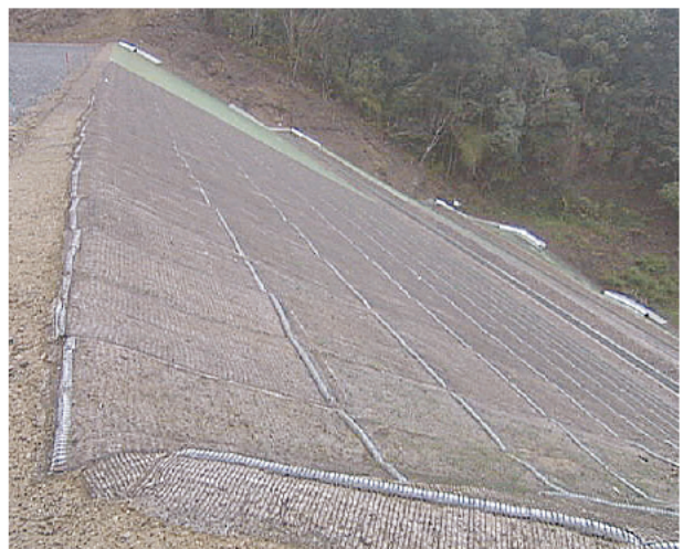
三重ステビアマットⅠ型、Ⅱ型 「植生マット」（志摩市浜島町浜島地内）
