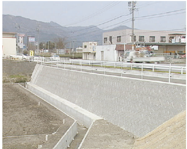
土木コンクリート積みブロック上ぶた式U型側溝 「コンクリート2次製品」（一般国道306号伊船バイパス）
