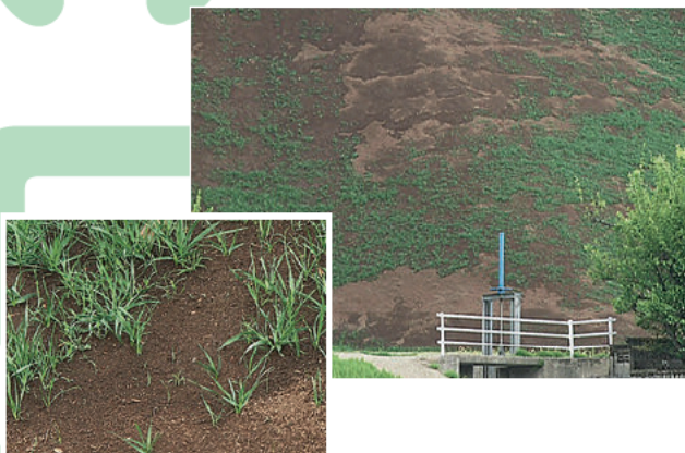
アースソイル 「緑化基盤材」(芸濃町大字忍田字城山)
