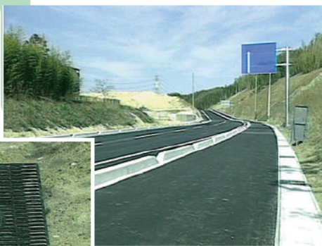
再生プラスチック嵩上げ材使用ダクトイルグレーチング 「リサイクルグレーチング」(主要地方道四日市朝日線)
