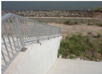
06 河川敷昇降口の階段脇の生活系ごみ
