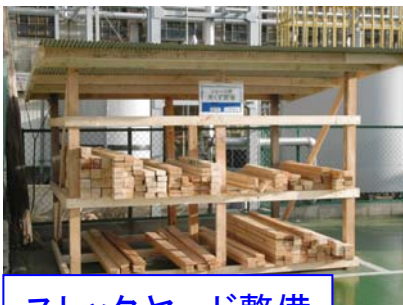
ストックヤード整備
