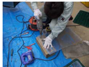
段々ドリル又はホールソーで通気口を開け、防虫ネットを張り付ける
