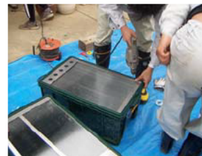
ステンレスの金具で固定します
