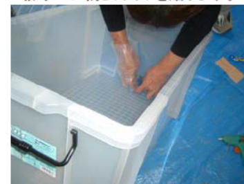
排水口に防虫ネットを貼ります。
