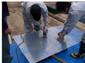
取り除いた蓋の一部にかぶせるポリカーボネイト(アクリル板)の加工
