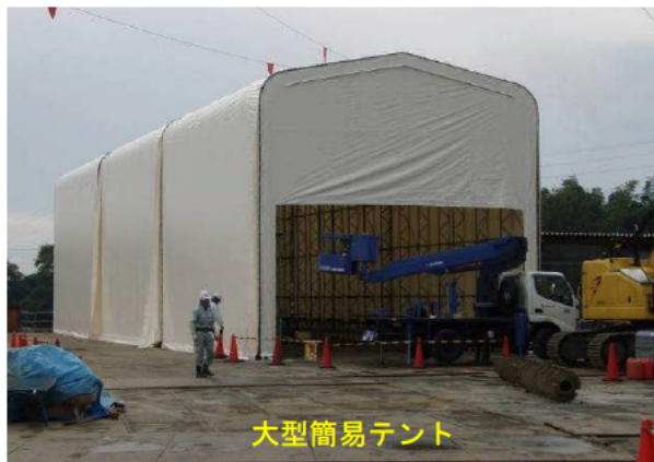
図 2.5 大型簡易テントと集塵機の一例
