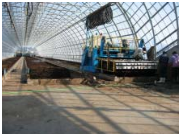
ハウス型の施設内に発酵処理を行う攪拌槽 (全長100m、幅3m、深さ2m)が3本あり、 それぞれに攪拌機が設置されている
