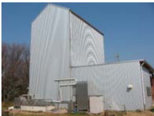
安濃町の廃棄物処理施設跡地を利用
