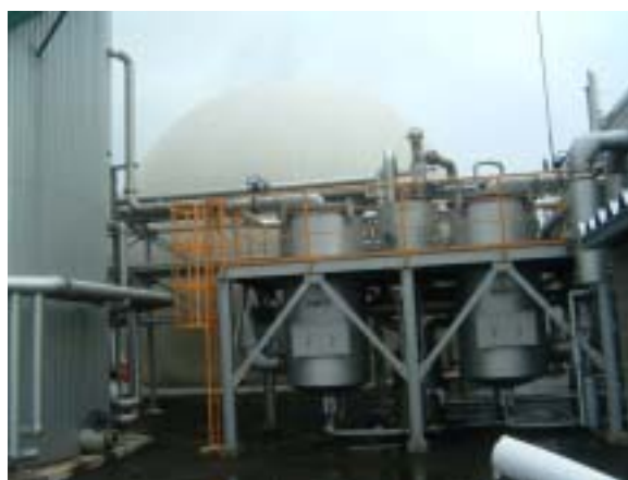
ガスホルダ(1,000m 3 )と脱硫装置
