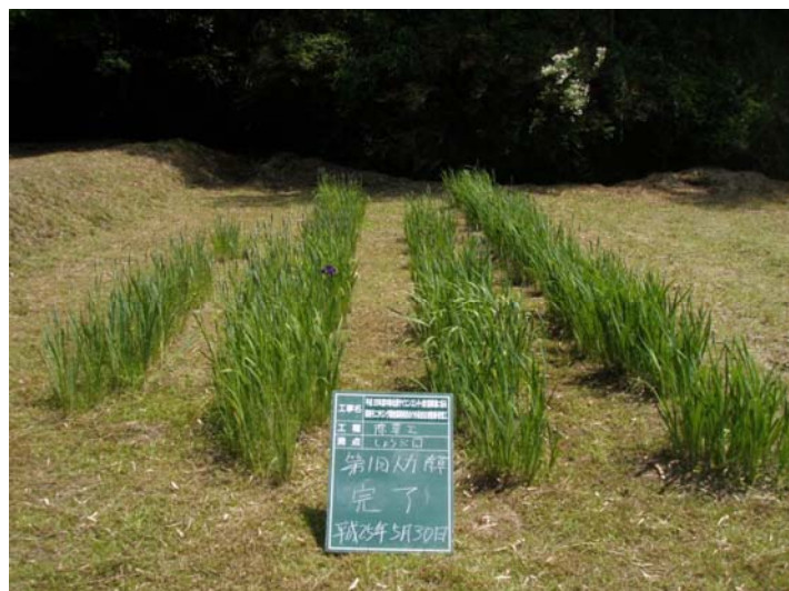
写真 4-3-6 整備状況(除草工(人力) : 除草後・ハナショウブ 植栽地 : 平成 25 年 5 月 30 日)
