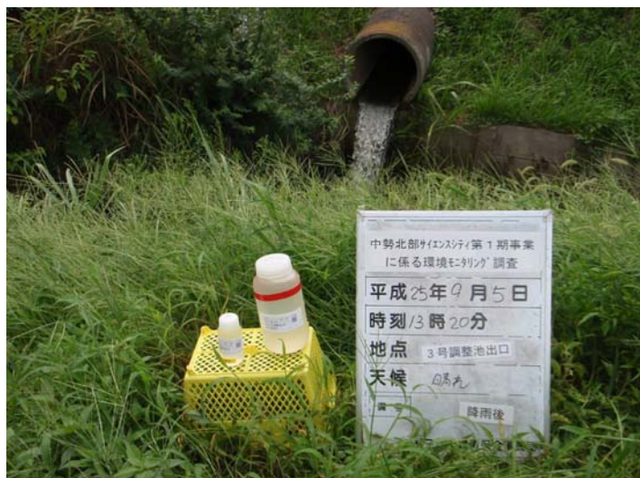
写真 4-1-23 濁水調査状況(豪雨時)(3号調整池出口)(平成 25 年 9 月 5 日)
