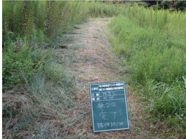
写真 4-3-4 整備状況(除草工(機械) : 除草後・保全区域 A・畦畔等 : 平成 25 年 9 月 22 日)
