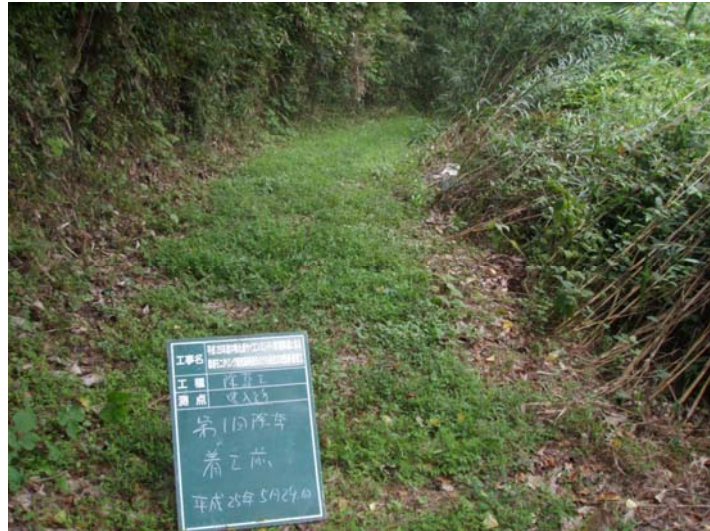
写真 4-3-13 整備状況(除草工：除草前・保全区域A・通路：平成25年5月29日)
