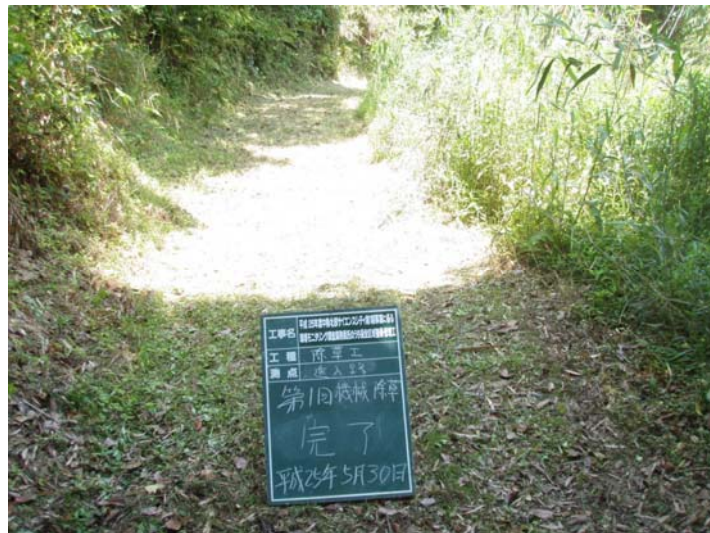
写真 4-3-14 整備状況(除草工：除草後・保全区域A・通路：平成25年5月30日)
