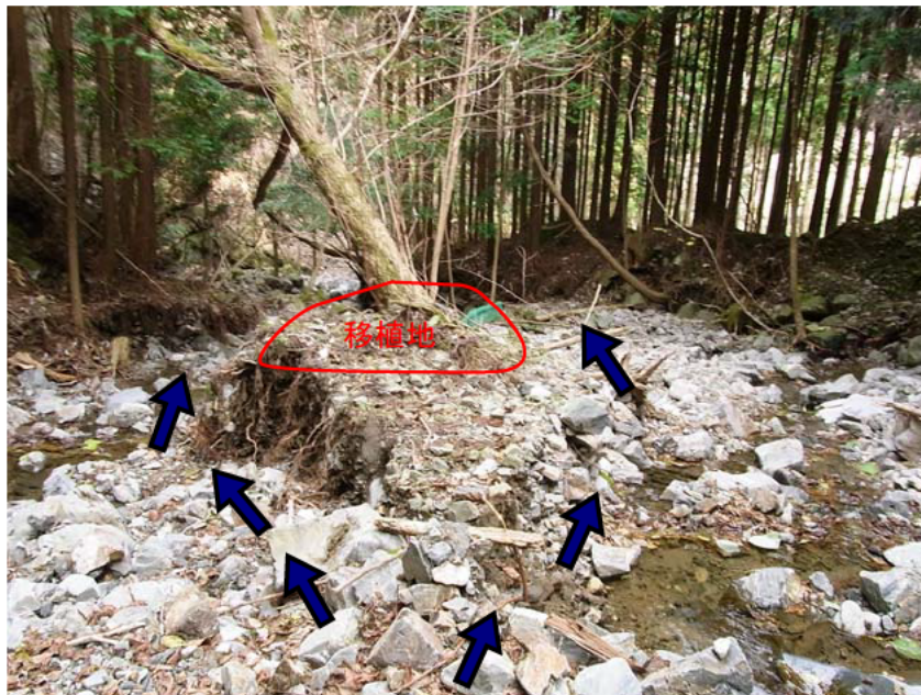
(平成 24 年度調査時：平成 24 年 12 月 5 日撮影)
