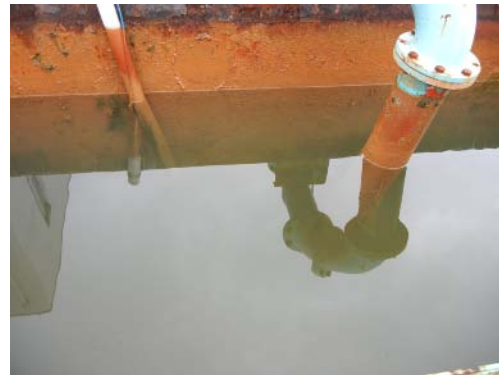
写真6 放流槽の状況 (5月24日調査)
