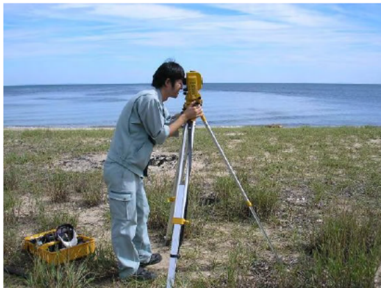
測量によるライン設置状況 (9月29日)
