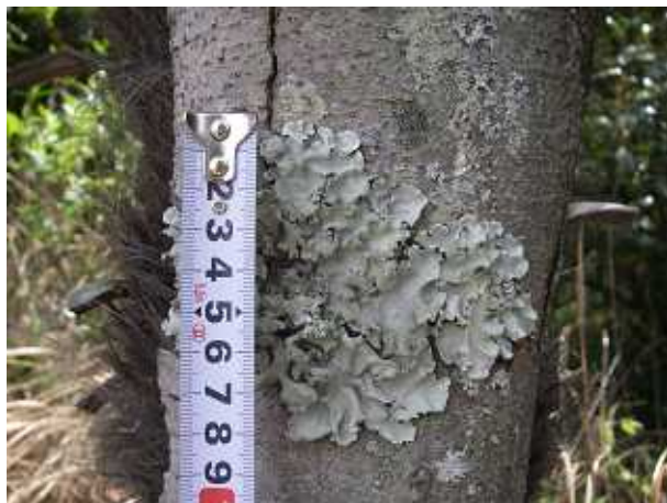
写真 6 - 2 - 10(3) 移設ウメノキゴケ - 2 下部 (平成 21 年 4 月 16 日)
