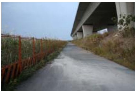
写真 6.2.4-1 伊勢湾岸自動車道脇の様子 (現地撮影 平成20年11月7日撮影)
