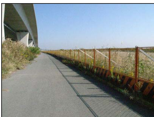
伊勢湾岸自動車道脇の様子
