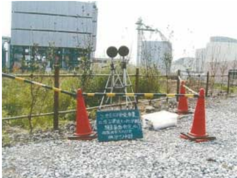
写真4 - 1 騒音・振動調査 測定状況 (No. 1 : 平成 15 年 5 月 21 日 ~ 22 日)
