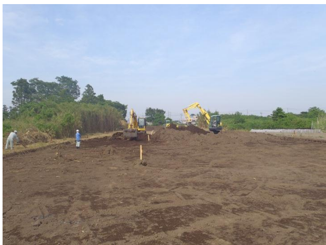
重機による表土掘削のようす（西から）
