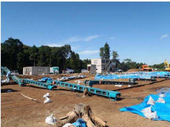
いよいよ始まる人力での掘削作業に備え、ベルトコンベアの設置を行いました。これによって掘った土を調査区の外へ効率よく排出することができます。
