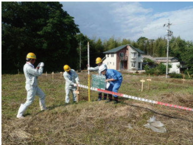
段階確認の様子
