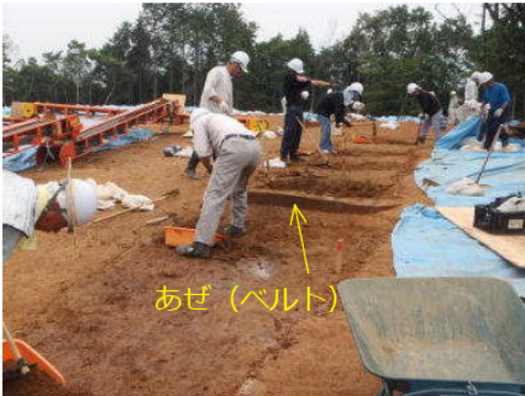
あぜを残しての掘削
