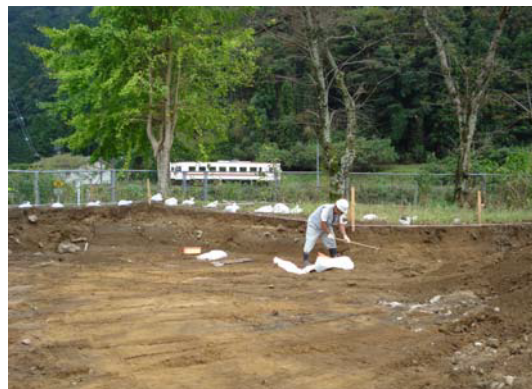
A地区表土除去状況
