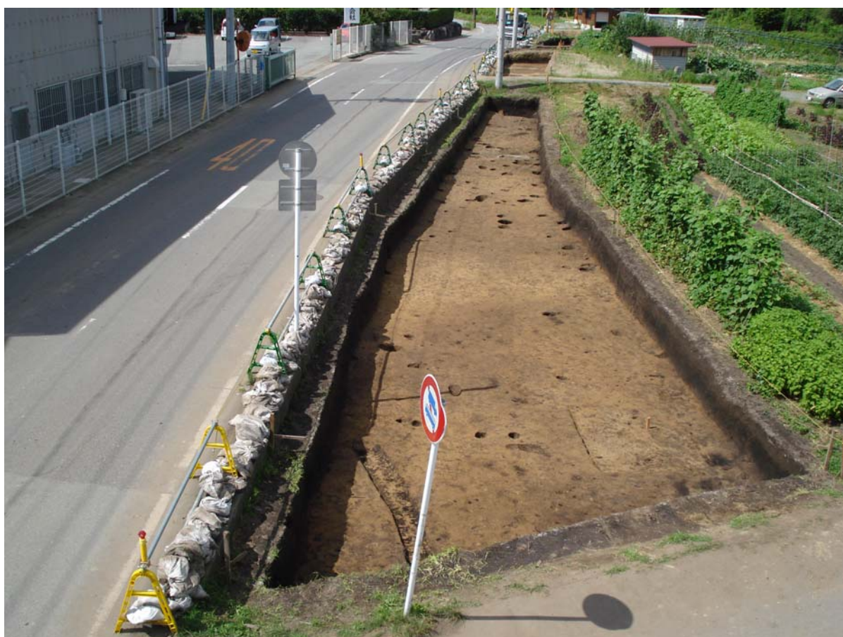
調査後の状況 (南から)
