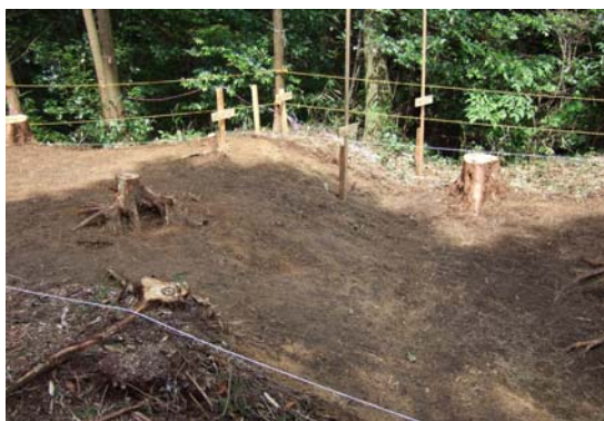
A2地区土塁(掘削前)
