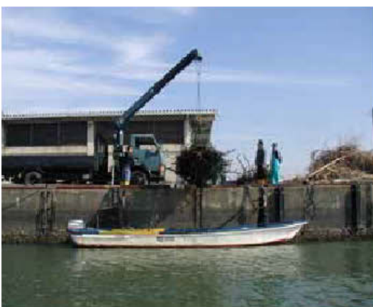
写真5 クレーンで岸壁に引き上げる
