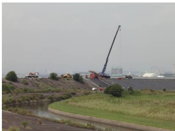
(写真3) 国土交通省が所管する部分に関しては修繕が行われている
