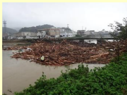
橋梁に大量の流木が押し寄せ水害を拡大
