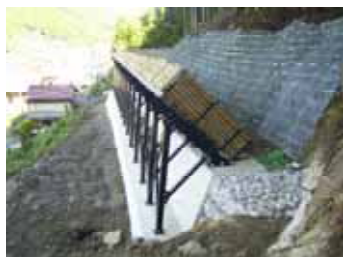
落石防護壁工：熊野市
