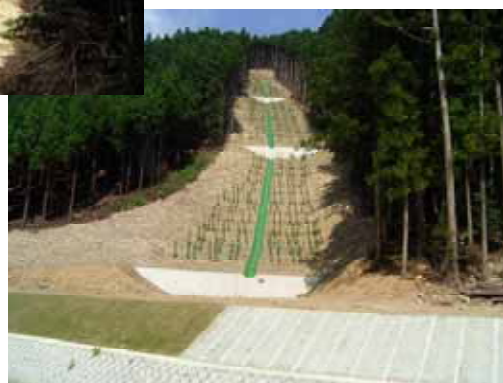
進む林地崩壊箇所の復旧(大台町(旧宮川村))
