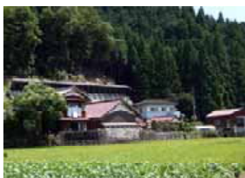
治山施設：熊野市
