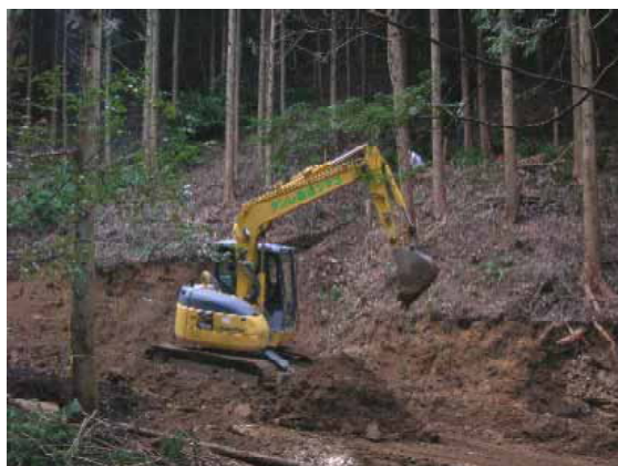
作業道の開設
