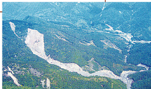
[大台町(当時は宮川村)の大規模な土砂崩れの状況]
