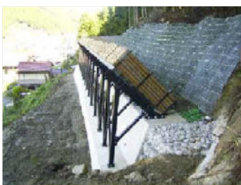
落石防護壁工：熊野市
