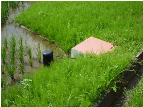
自動給水栓の設置
