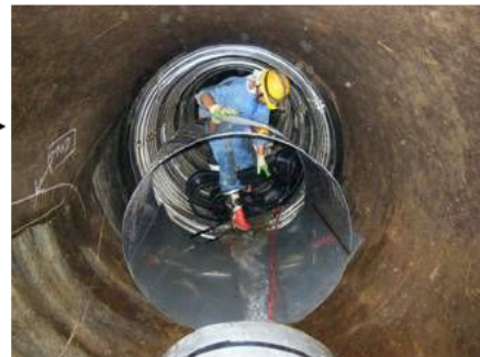
用水管の補修
