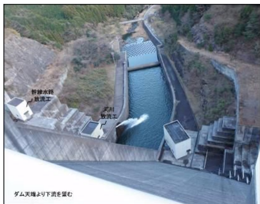
安濃ダム小水力発電施設整備予定箇所
