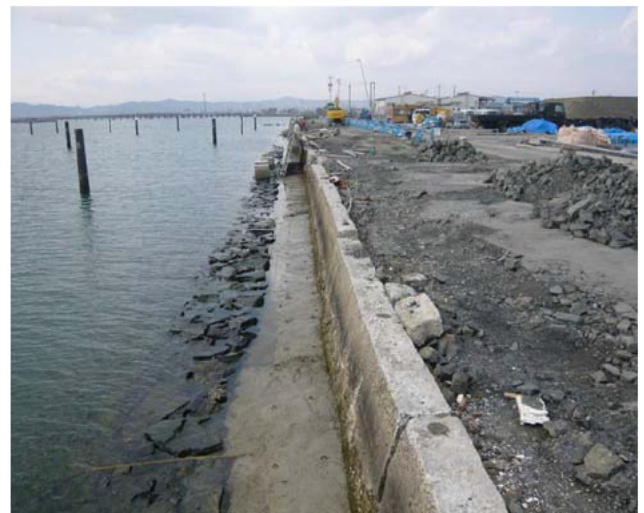
荒浜漁港 船揚場護岸 (H25.4.4)
