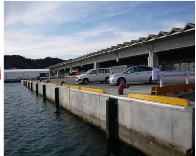
女川漁港 -5.5m岸壁【魚市場前】 一部完成 (H24.12月)
