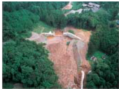
藤原町土石流発生現場
