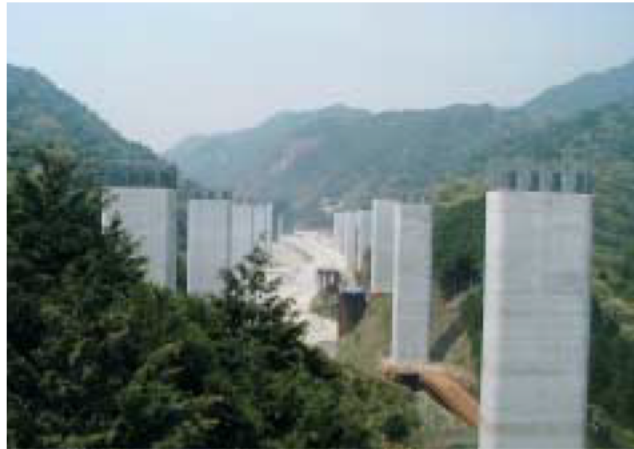
第二名神高速道路建設現場
